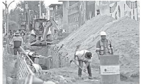
Los trabajos comenzaron el 5 de enero. FERNANDO CARRANZA
