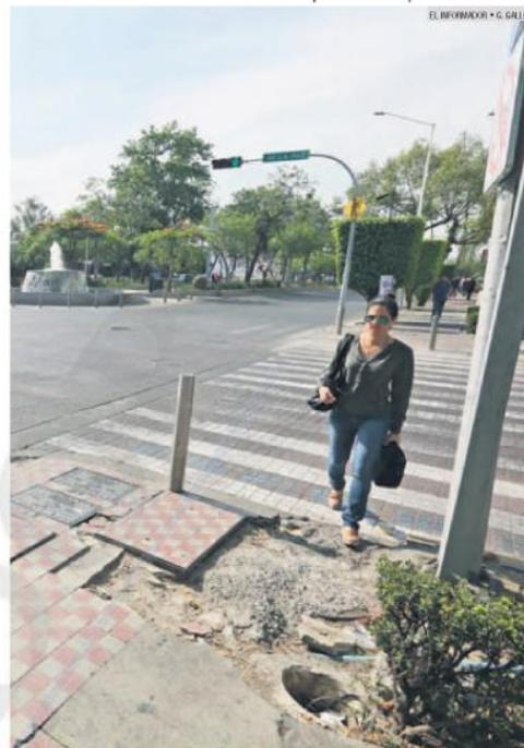
**AFECTACIONES.** En diversas partes de Chapultepec los adoquines ya no existen e incluso desapareció parte del concreto, como en el cruce de López Cotilla.
