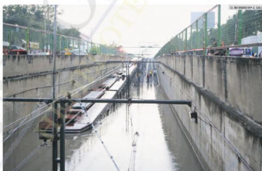
TREN LIGERO. Estación Dermatológica de la Línea 1, entre los puntos afectados durante las últimas inundaciones.
