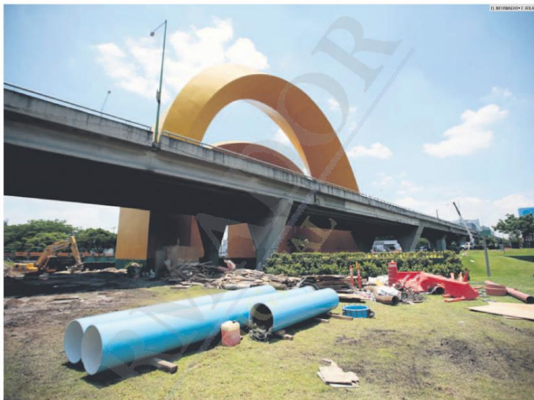
ARCOS DEL MILenio. El colector que se construyó en la zona ya está en funcionamiento. Forma parte de las 11 obras para mitigar las inundaciones en el AMG.
