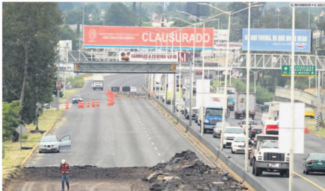
NUEVA ETAPA. Esta semana iniciará la demolición del cuerpo Norte de Periférico, de Carretera a Chapala hacia 8 de Julio.
