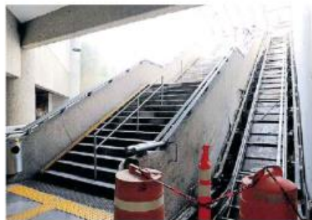
Tome sus precauciones ante la reparación de las escaleras. AGAPITO ESPINOZA.
