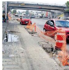
La obra inicia en la calle Uno hasta Washington y viceversa.
