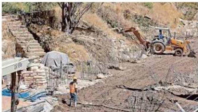
■ Las obras de edificación continúan gracias a una medida cautelar del Tribunal de Justicia Administrativa.
