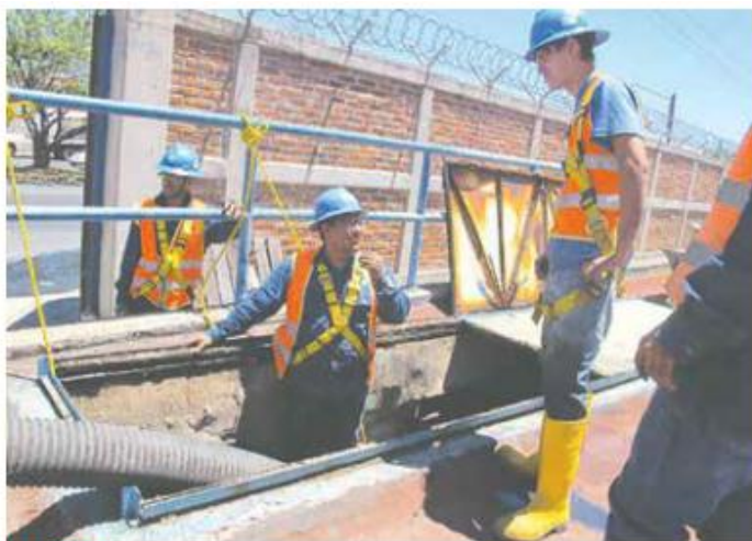
LABORES. Los puntos más importantes donde se está trabajando son la Planta Chapala y las plantas potabilizadoras 1 y 2.
