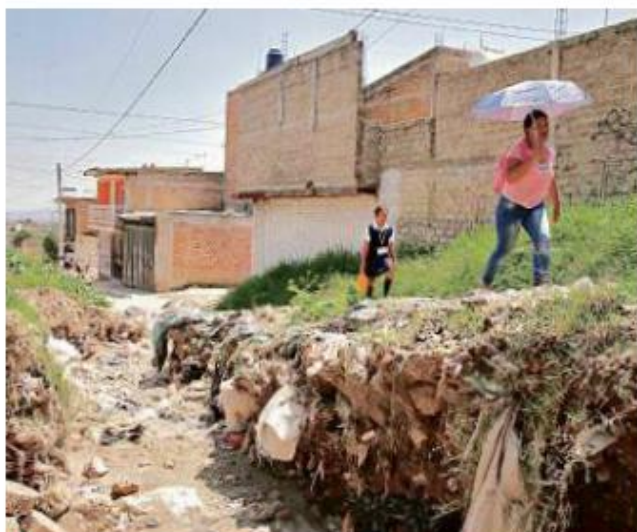
■ En la Calle Jardines Tapatíos, entre Jardín de los Belenes y Flor de Orquídeas, el desgaste de las lluvias causó un desnivel.
