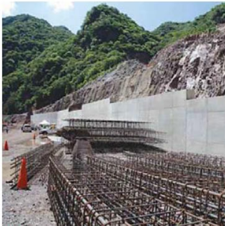
ATRASO. Se había dicho que la presa quedaría terminada a finales de este año, lo que será imposible.
