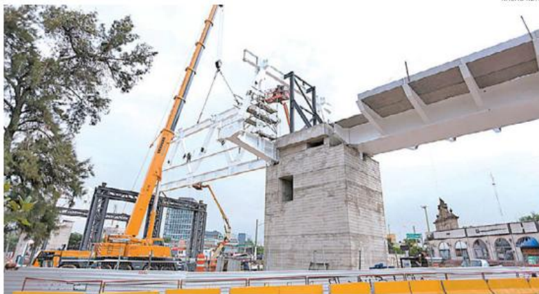
La construcción se proyecta entre la estación Basílica de la L3 y los Arcos zapopan
