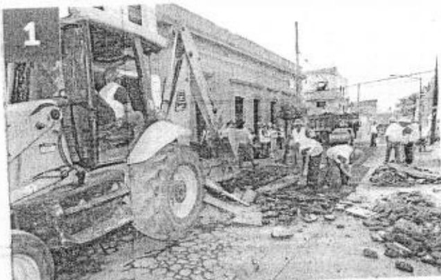
1 A los tramos afectados por "piel de cocodrilo" (grietas) o con baches se les realizarán cortes y se retirará el material gastado.
