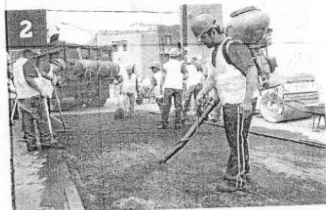
2 Una mezcla líquida es impregnada en la zona para que el nuevo material se adhiera mejor y garantice dos años en buen estado.
