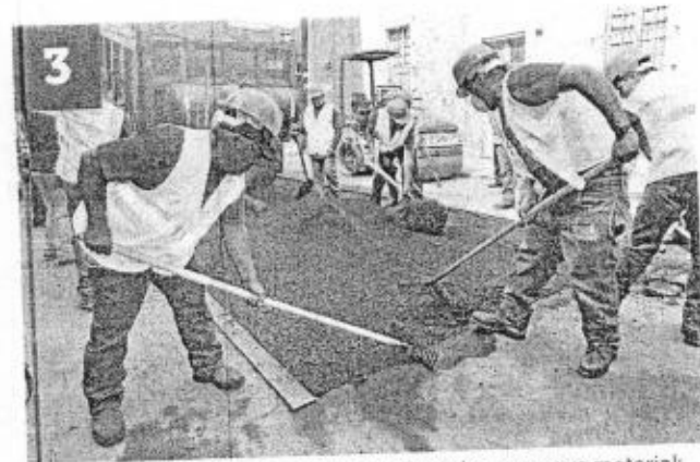
3 El hueco por el retiro de asfalto es rellenado con nuevo material; en el caso de la repavimentación, se levantará toda la carpeta vieja.
