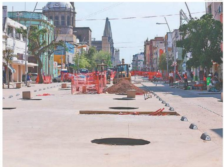
Se trabaja en retiro de concreto en banquetas y en la instalación de línea de agua potable
