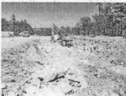
Los trabajos en la carretera iniciaron en 2008
