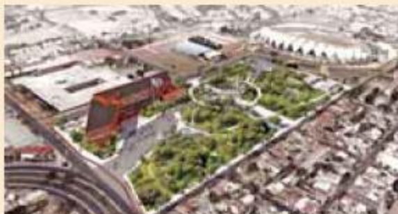
La obra conformará un corredor que comunicará el centro de Zapopan con el núcleo universitario de Los Belenes. ARCHIVO
