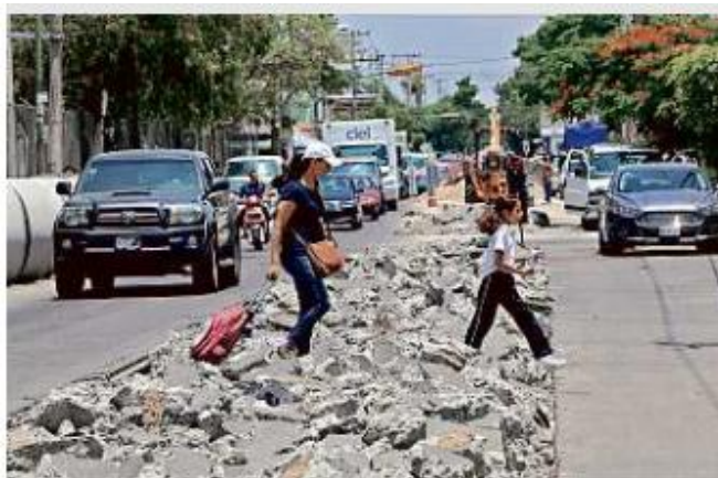
■ Por el Amparo interpuesto por vecinos, el SIAPA sólo concluirá los trabajos en la Calle Medrano.
