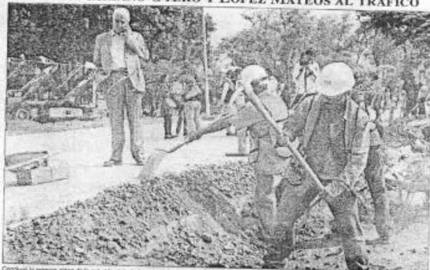
Concluyó la primera etapa de la solución vial en el cruce de las avenidas Mariano Otero y López Mateos, por lo que desde mañana se abrió al tráfico en ese punto. El titular de la SED, Roberto Davalos Lugo, informó en un recorrido por la zona que a partir de este miércoles se cancela parcialmente los niveles de la glorieta de Mariano Otero; los nuevos trabajos se reanudarán durante tres meses ■ Foto: Fernando Carrasco
