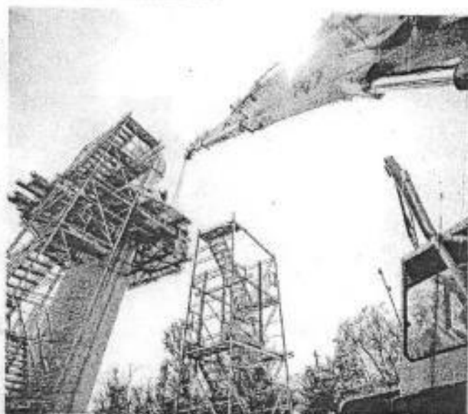
AVANZA. Las obras del Tren Ligero se realizan simultáneamente en Zapopan, Guadalajara y parte de Tlaquepaque.
