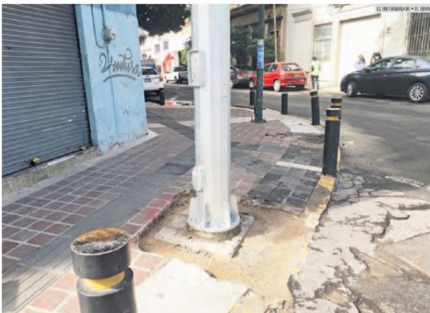
SEÑALAMIENTO. Los vecinos y comerciantes afirmaron que los trabajos se realizaron hace más de dos semanas.
