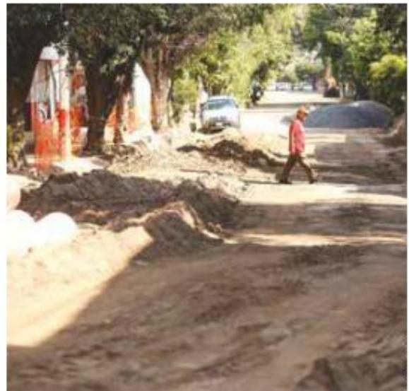
se dio el banderazo de salida, durarán cuatro meses. “Con dichas obras se tendrá la renovación de 4 mil 530 metros cuadrados y la intervención de 350 metros lineales, guarniciones, renovación de banquetas, renovación de las redes de agua potable y de alcantarillado y balizamiento”, informó el ayuntamiento tapatío.
