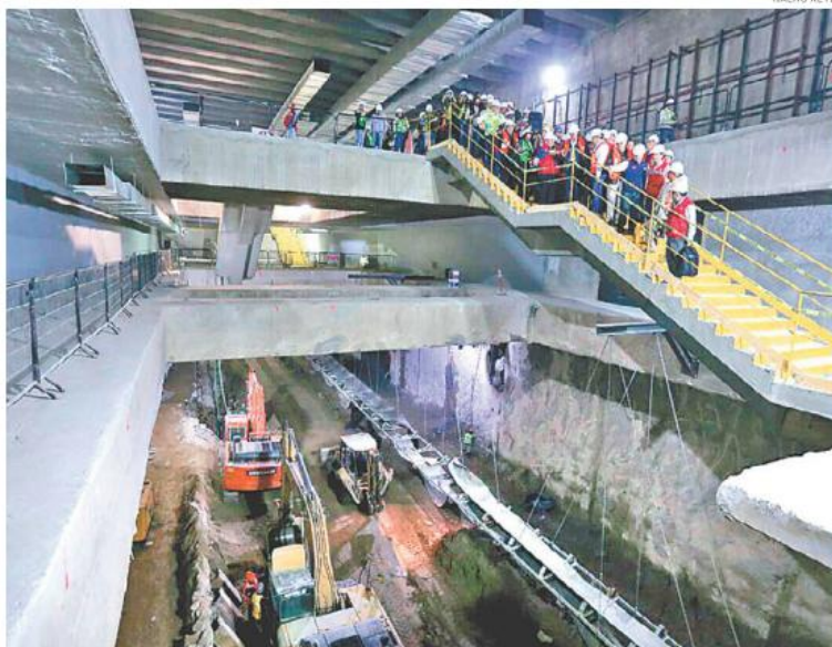
Ayer se supervisó la obra de la estación La Normal y el Centro de Transferencia Modal de la L3
