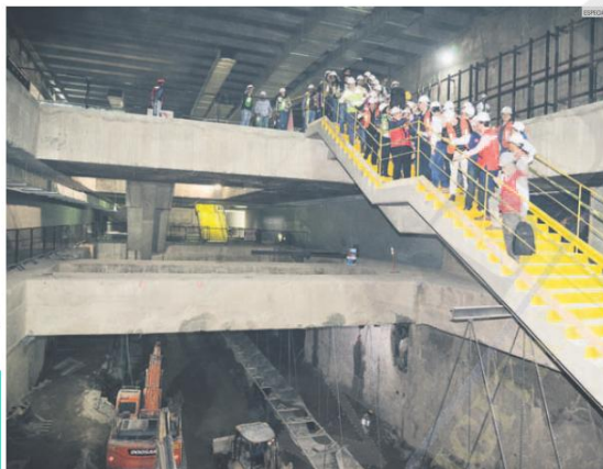
TOMA FORMA. En el recorrido de ayer por la que será la Estación La Normal, ya se puede apreciar parte del andén por donde los usuarios podrán abordar los trenes de la Línea 3.
