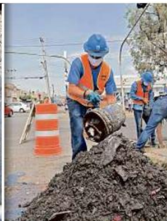
■ Después de drenar la boca de tormenta, personal del Siapa procede a sacar los residuos sólidos a pala y cubeta. Con ello buscan evitar inundaciones.
