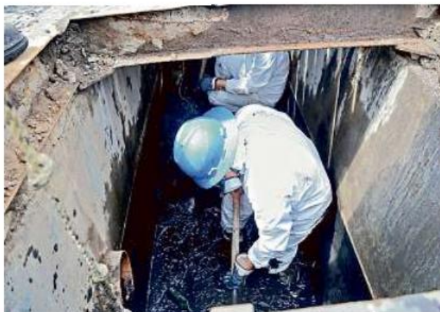
■ Después de drenar la boca de tormenta, personal del Siapa procede a sacar los residuos sólidos a pala y cubeta. Con ello buscan evitar inundaciones.
