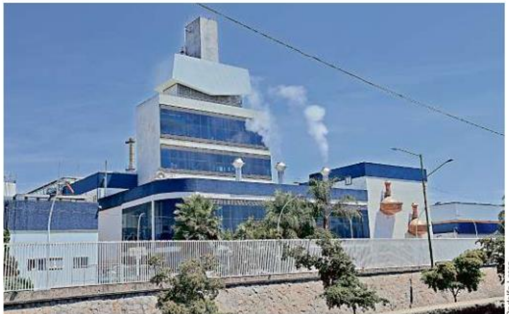
■ Ayer se veía salir humo blanco de las calderas de Cervecería Modelo de Guadalajara, previendo el inicio de la reactivación económica de la planta.
