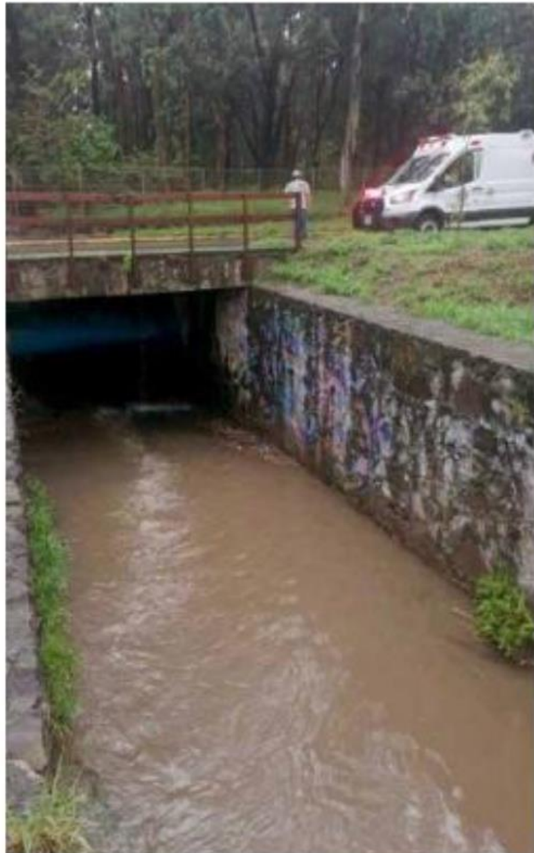
LES LLEGA EL AGUA. Los bomberos atendieron cinco puntos de inundación en la vía pública.
