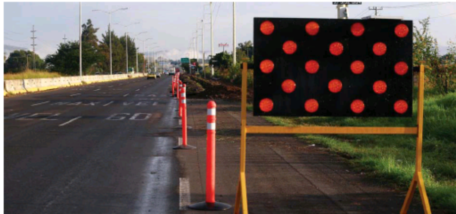
En la recta final el reencarpentamiento del Periférico. CORTESÍA GOB JALISCO.
