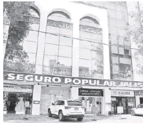
Las instalaciones. FRANCISCO RODRÍGUEZ
