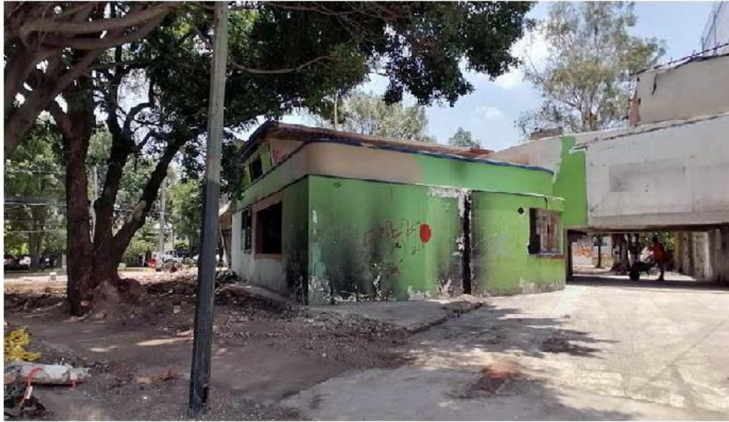
En la construcción habitaron hasta 50 personas. CORTESÍA
