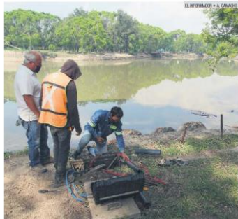
MANTENIMIENTO. Trabajador es cambian cables en el vaso regulador de El Dean.
