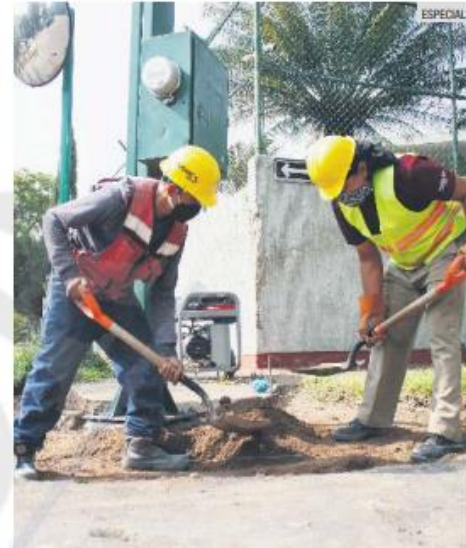
OBRAS. Allí se destina parte del dinero federal.
