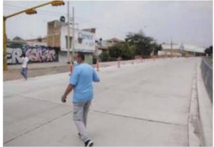
MIMACROPERIFÉRICO. Las obras han provocado reducción de carriles.
