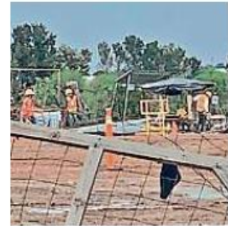
■ Los trabajos del súpergasoducto continúan.
