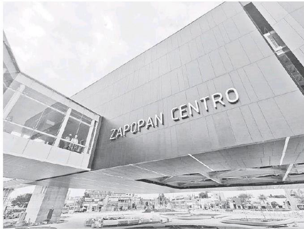
En las terminales falta colocar techumbres y luminarias. ANTONIO MIRAMONTES.
