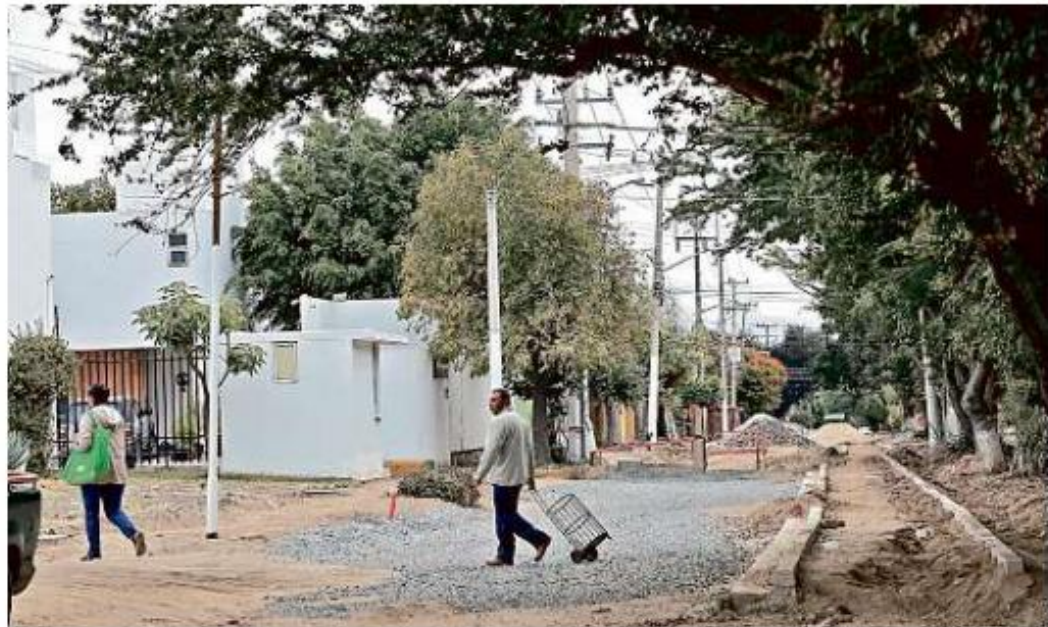
Actualmente se realizan obras de rehabilitación en el Andador Aurelio Ortega.
