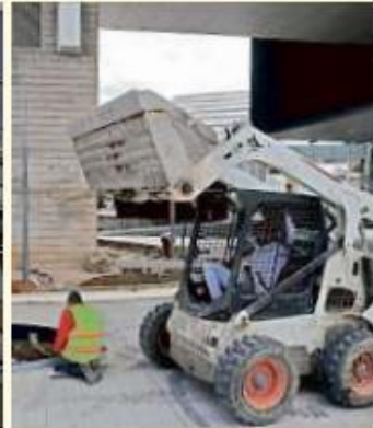
■ En la estación Zapopan Centro aún se hacía obra exterior.
