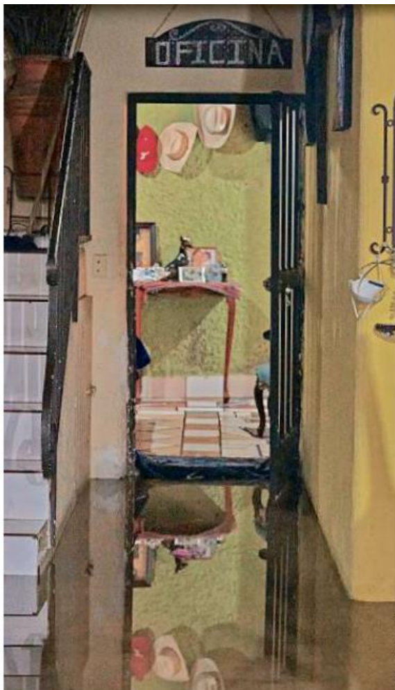
Con la lluvia varias casas y comercios quedaron inundados en Jocotán, la tarde de ayer.
