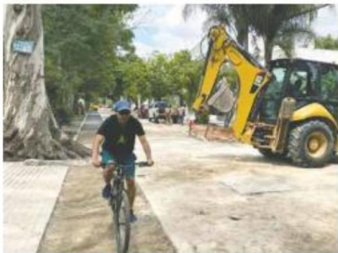
ZAPOPAN. El cierre es originado por la ampliación del camellón de la avenida Aurelio Ortega.
