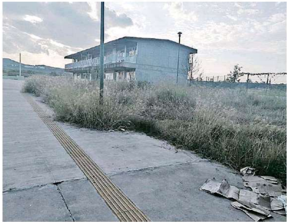
La escuela Marie Curie en El Salto luce muy descuidada. CORTESÍA
