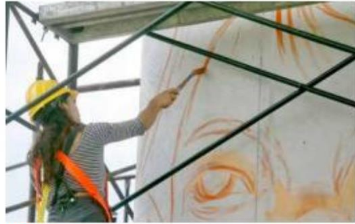
LUGAR. La primera etapa los trabajos se centra en tres pilares de la estación Zapopan Centro.
