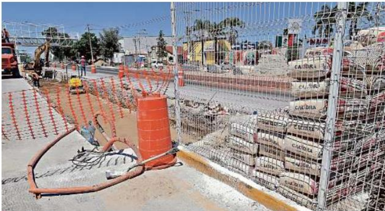
En el Periférico se construyen actualmente las estaciones de Mi Macro Periférico.
