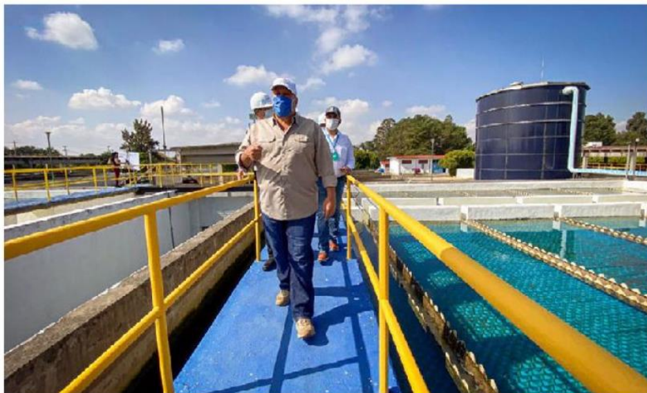
El gobernador entregó obras de la Planta Potabilizadora No. 3 de San Gaspar, en Tonalá. ESPECIAL
