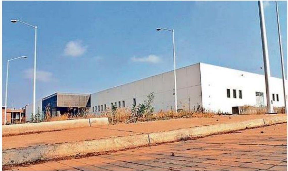
Actualmente, el hospital se mantiene en desuso.
