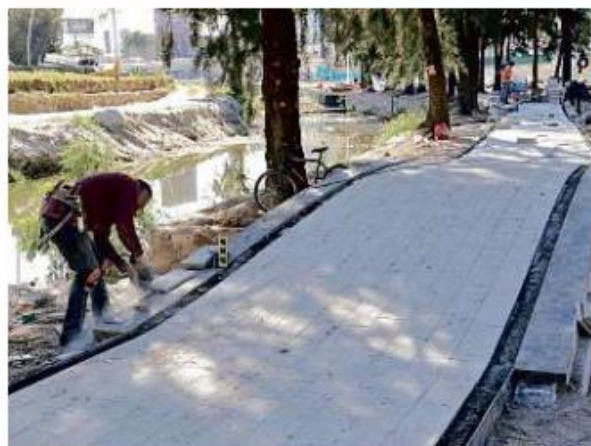
Los puentes más avanzados están a la altura del ingreso a Los Colomos y al Parque El Polvorín.
