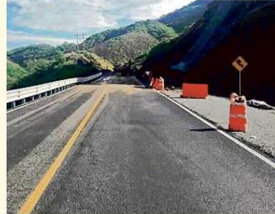
■ En la carretera permanece cerrado el tramo El Ramal-Compostela, por trabajos de estabilización de taludes.
