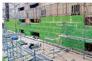
Panelos que se instalan en las fachadas de cinco edificios de San Lázaro, donde se ubican comisiones y oficinas.
