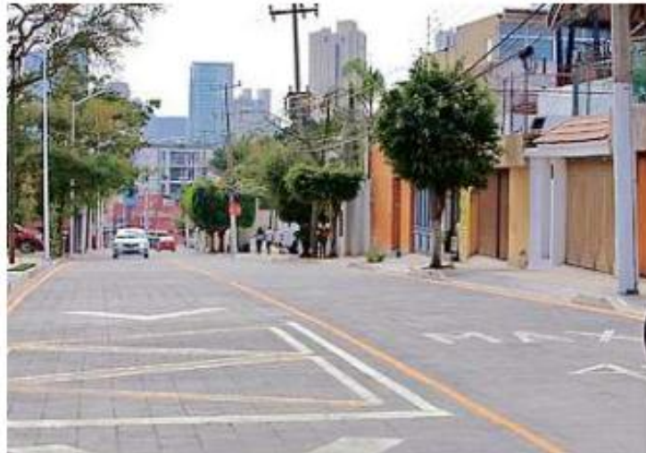
■ Se pavimentaron con concreto hidráulico 650 metros lineales.
