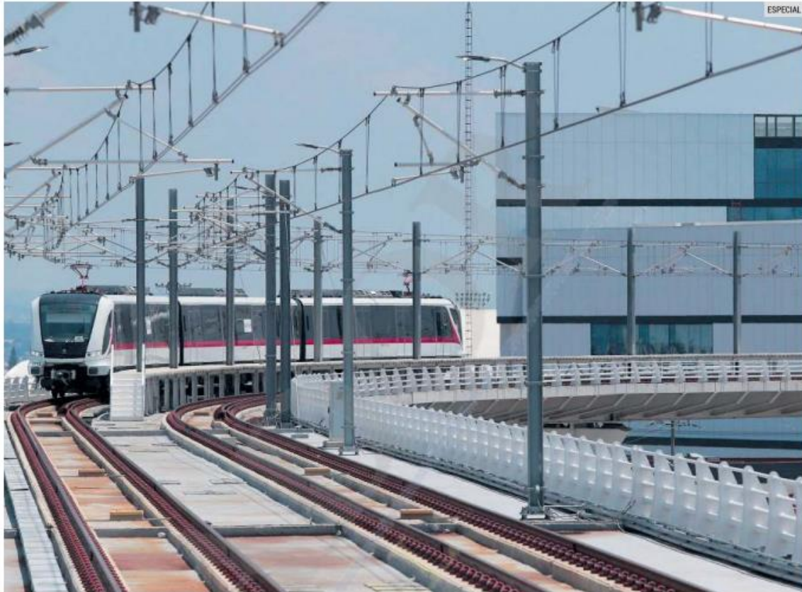
LÍNEA 3. El nuevo medio de transporte público no se ha salvado de los robos, principalmente del sistema de cables.
