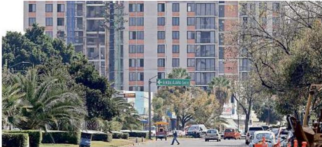
■ Sobre Avenida Federalismo se construyen varios complejos de departamentos.
