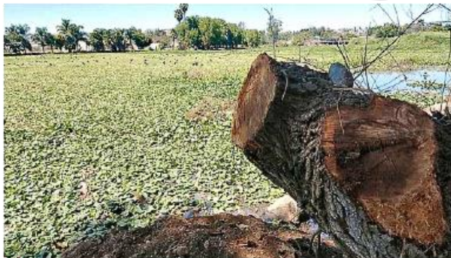
■ En la zona fueron removidos algunos árboles para dar paso a las obras.
