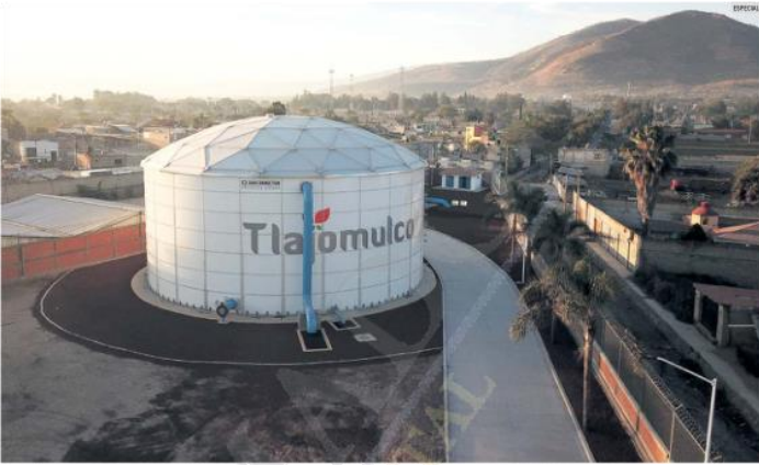
LOGROS. La actual administración concluyó la planta de Tlajomulco 1 en Zapote del Valle y más macrotanques para dar mayor abasto de agua.
