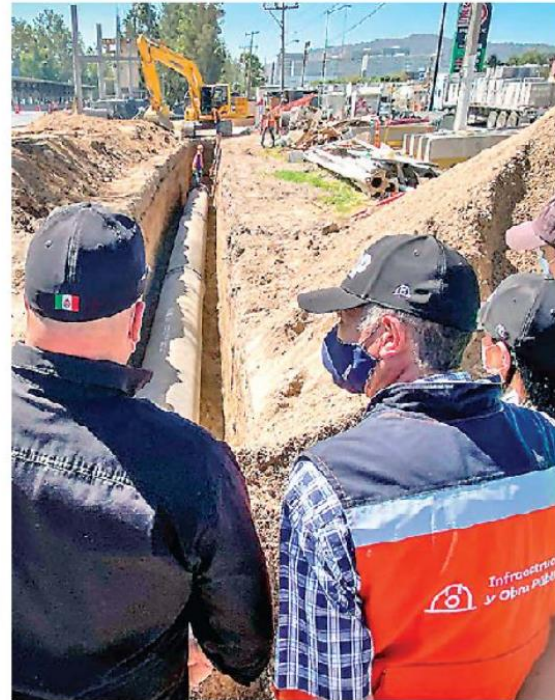
Alfaro supervisó los trabajos del Acuaférico. ESPECIAL
