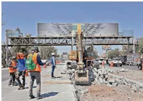
En Periférico Sur el 12 de marzo ponían cimientos.
