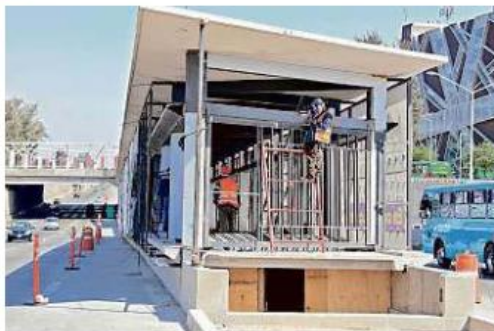
Estación frente al CUCEA, donde instalan herrería y vidrios.
