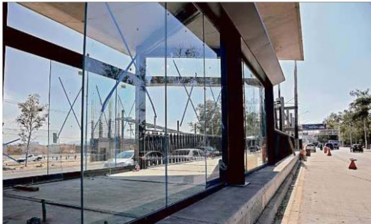
Estación ubicada en Periférico Norte donde instalaron ya los vidrios.
