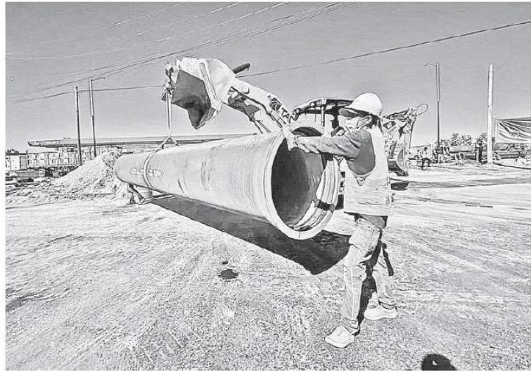
Siguen los trabajos del acuaferico en la ciudad. CORTESÍA GOBIERNO DE JALISCO
