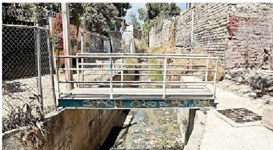
El canal es pluvial, pero hasta en primavera va cargado de aguas negras y despiden malos olores.
