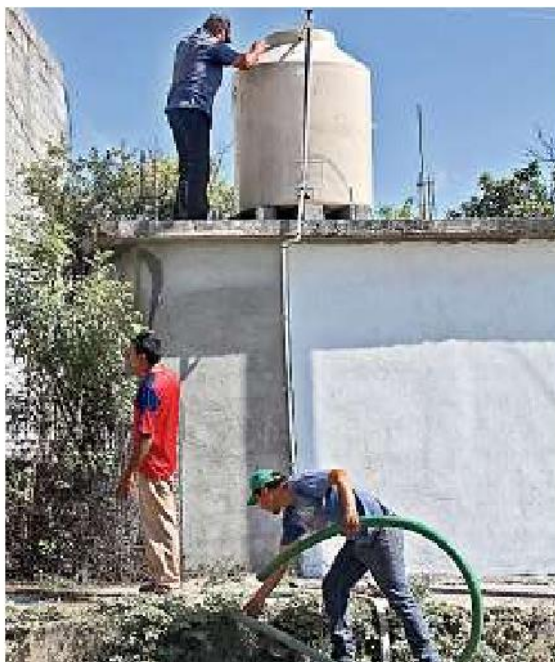
En Jalisco sólo el 38.8 por ciento de la población cuenta con cisterna o aljibe para almacenar agua potable, mientras 77.2 por ciento tiene un tinaco.
