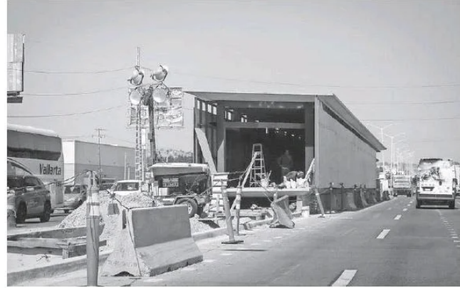
A marchas forzadas los trabajos en las estaciones. ANTONIO MIRAMONTES
