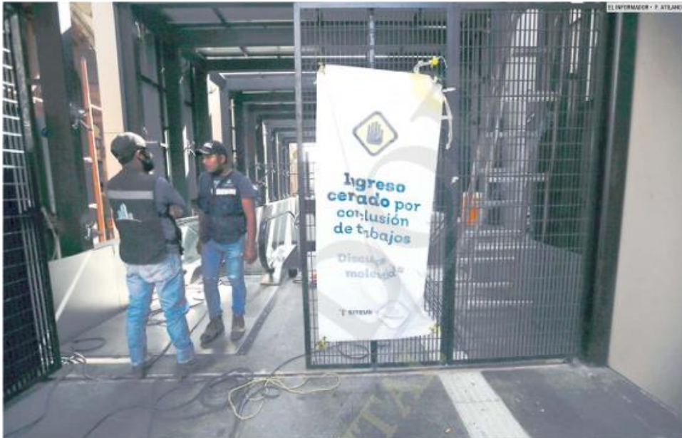
DESPERFECTOS. La ruta inició operaciones en septiembre pasado, pero presenta fallas en el suministro de agua potable en las estaciones, patios y cocheras. Hay rezagó en la planta de tratamiento de agua, problemas en escaleras y elevadores (Estación Catedral).
