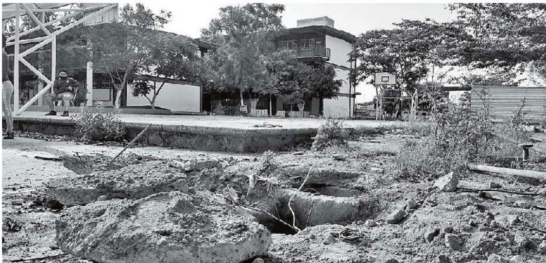
La mayoría ha sufrido el robo de cableado. MARÍA RAMÍREZ
